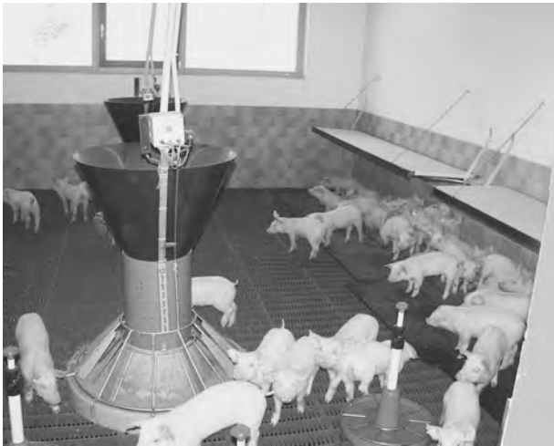
Abb. 1: Abteil mit Fista-Zonenheizung Zone-heating system
