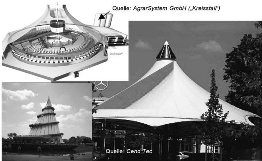
Abb. 1: Gebäude mit Hochpunktmembranen
