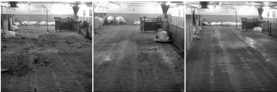
Abb. 1: Bodenzustand vor, während und nach der Reinigung Fig. 1: Condition of the floor before, during and after cleaning
