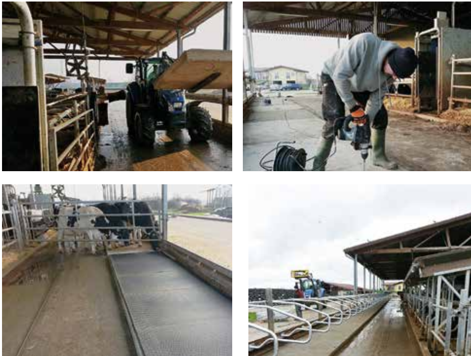
Abb. 1: Installation der erhöhten Fressplätze in vier Schritten (@Zinsel)
