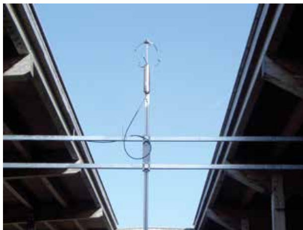
Abb. 2: Ultrasonic Anemometer 3D (Fa. Thies) im nicht überdachten Laufhofbereich
