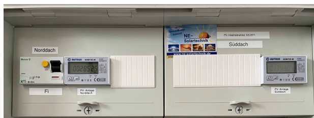
Abb. 1: Messgeräte und Tastkopf zur Erfassung von Verbrauchs- und Erzeugungsdaten (© F. Müller)
