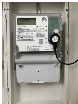
Abb. 1: Messgeräte und Tastkopf zur Erfassung von Verbrauchs- und Erzeugungsdaten (© F. Müller)
